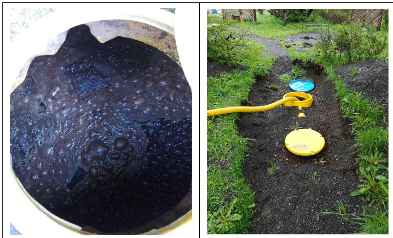
Figura 2. Chequeo y mantención de sistema de fosa séptica
